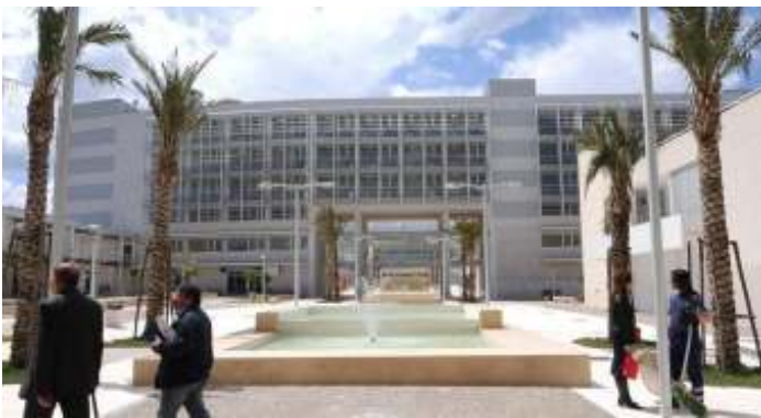
CENTRO DIREZIONALE- QUARTIERE SAN PAOLO BARI NUOVA PIAZZA EUROPA VICINO PARROCHIA SAN GABRIELE DELL'ADDOLORATA.
