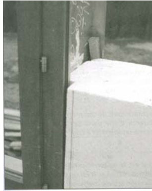
Maçonnerie de blocs en béton cellulaire autoclave
