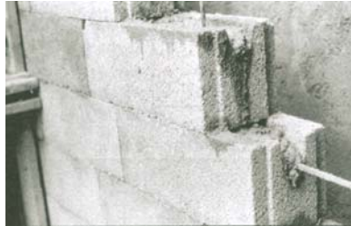
blocs de béton permettant la mise en place d'armatures horizontales et verticales
